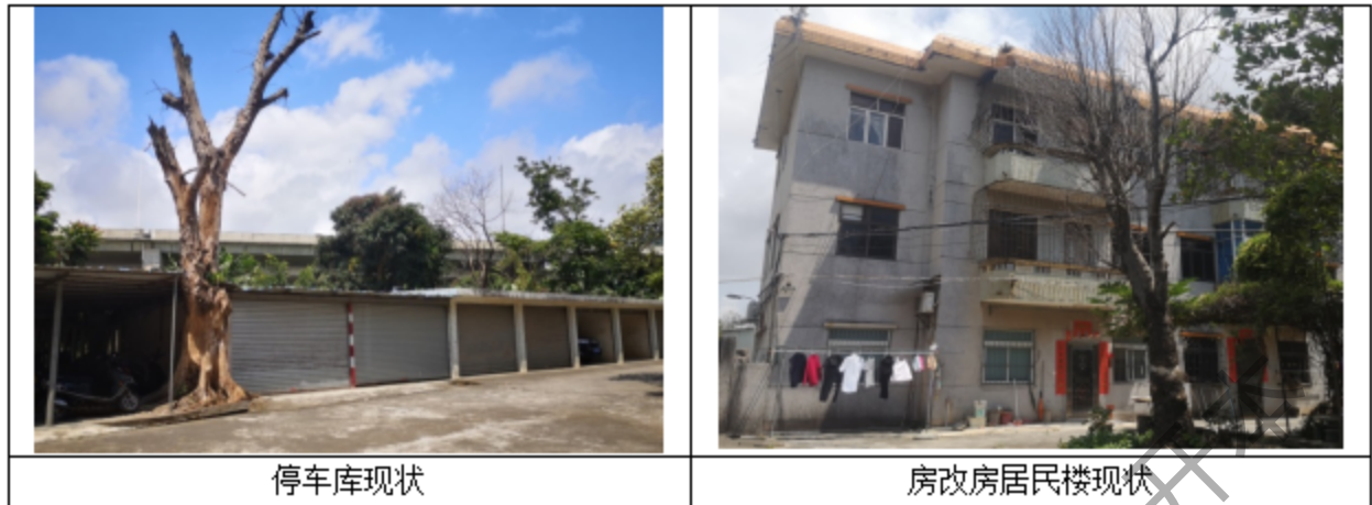
图 3.2-2 洪湾泵站施工场地周边现状照片
