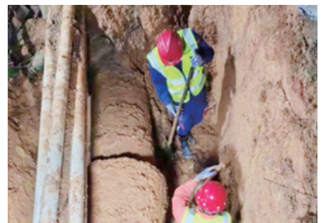
白莲新村抢修现场
