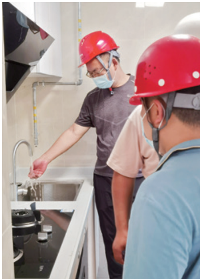
▲ 检查供水设施通水状况
