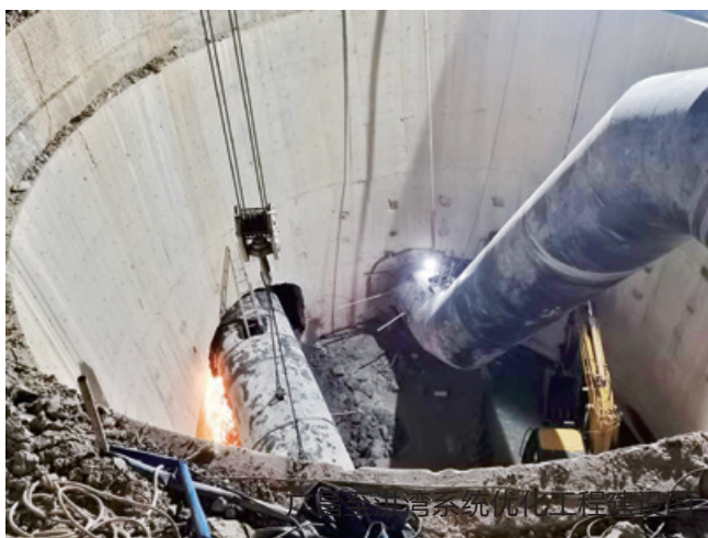
接收井第一根井内联通管施工 珠海水控集团 卢建华 摄
