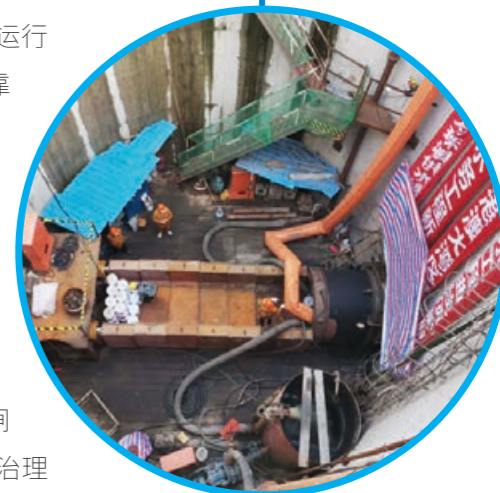
广南梅供水管道工程
