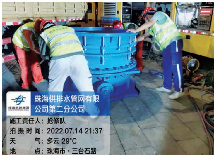
▼晚上9点37分,管网公司工作人员在三台石路更换DN1200阀门
