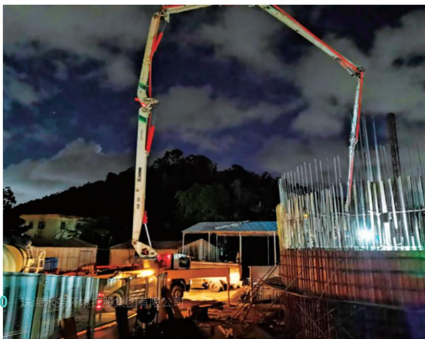
顶管井井壁浇筑作业现场
