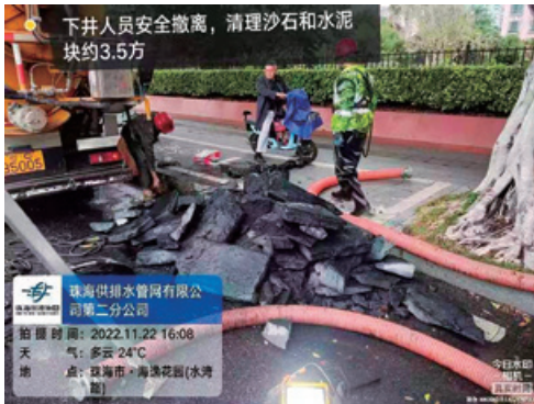
总共清理沙石和水泥块约3.5方
