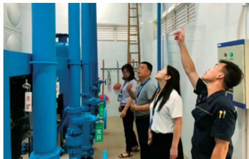
检查考场二供泵房情况
