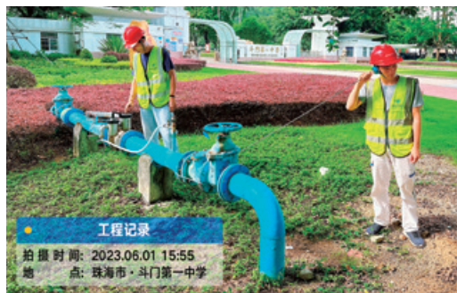
检查考场周边阀门井、供水管线和消火栓情况
