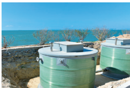
▲ 三角岛生活污水处理工程
